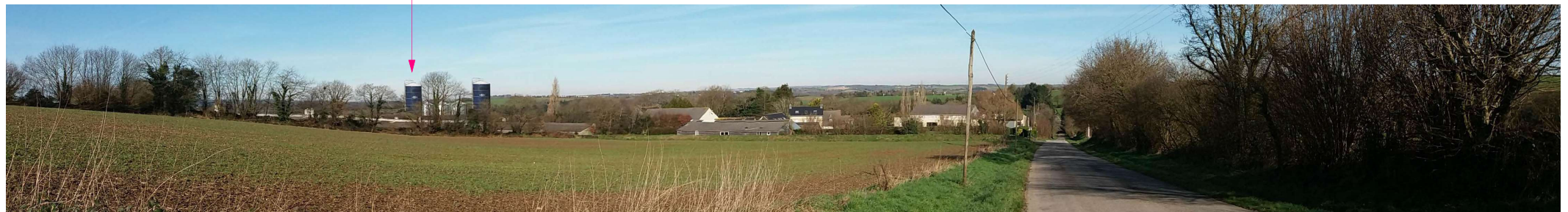
Vue 7 après travaux
