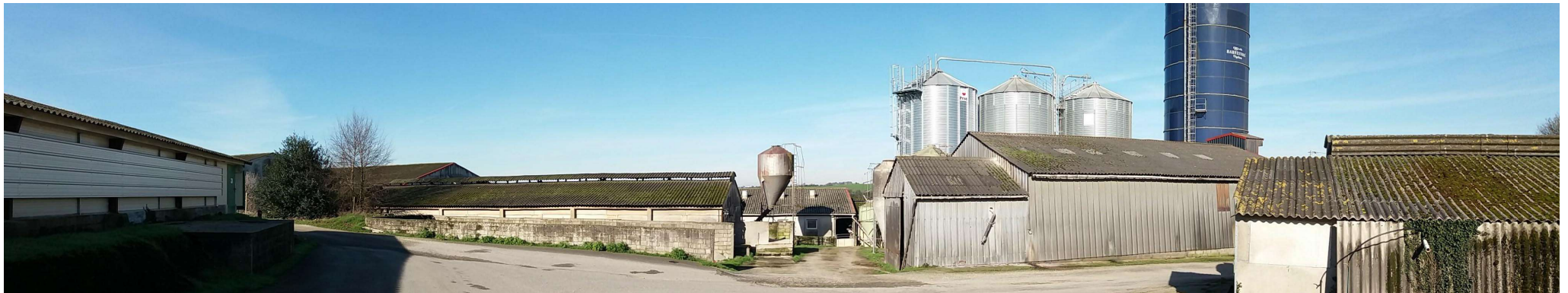
Vue 6 avant travaux
